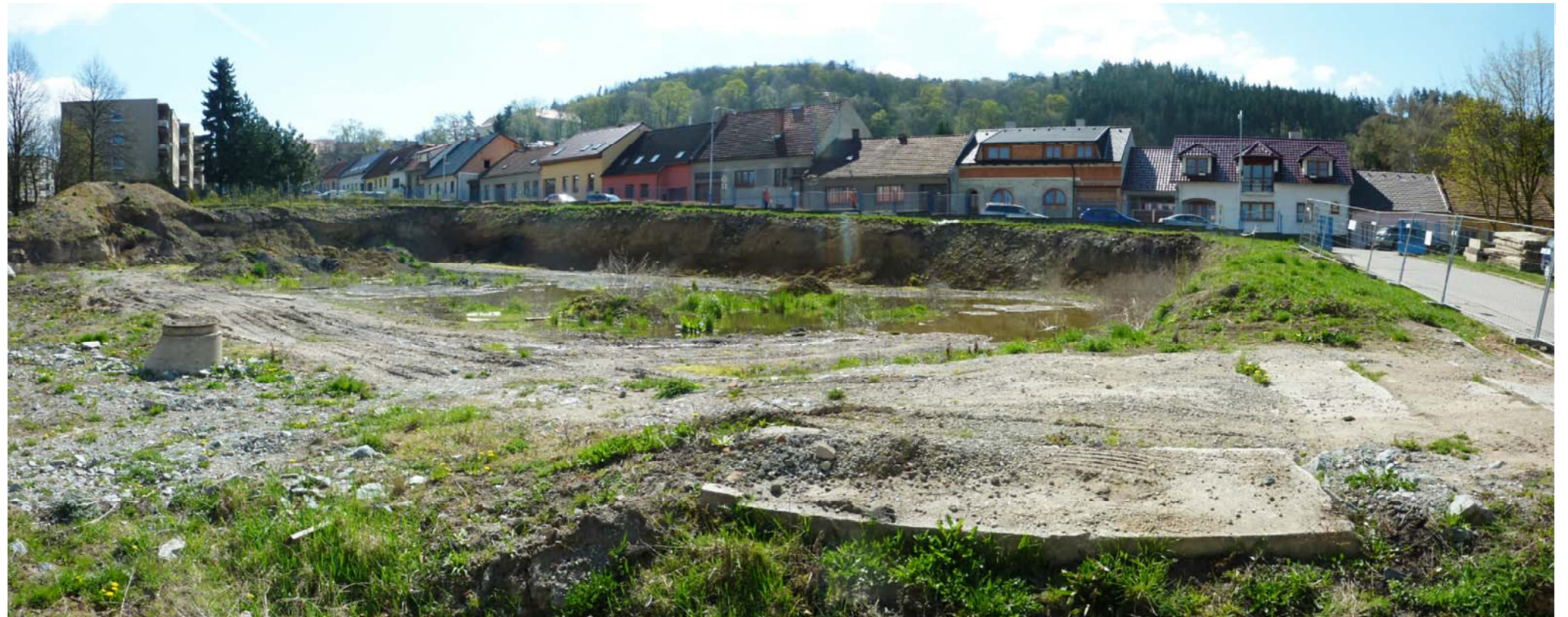
POHLED OD AUTODÍLNY OD SEVEROZÁPADU
