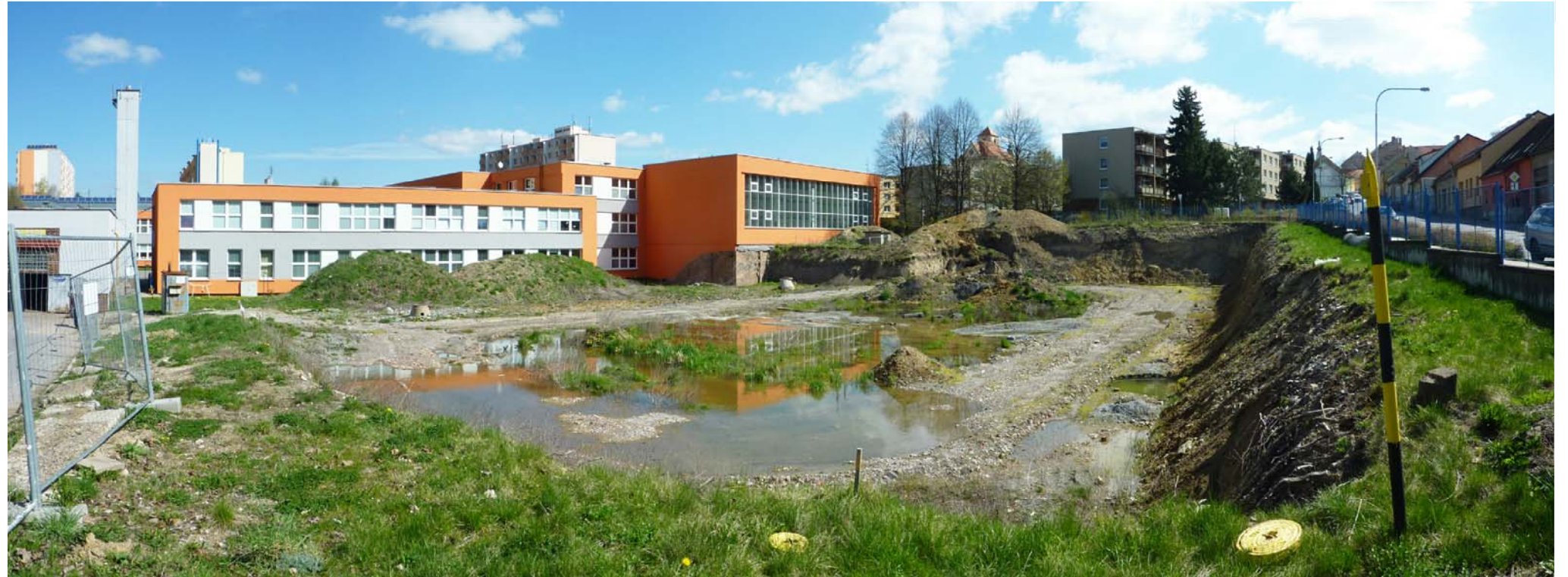
POHLED OD CHODNÍKU OD JIHOZÁPADU
