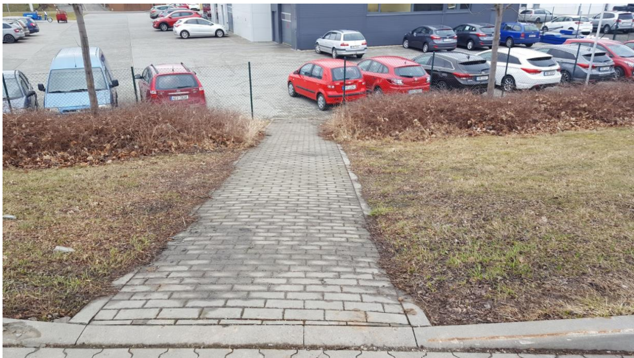
Obrázek 26: Chodník nenavazující na průchod oplocením
