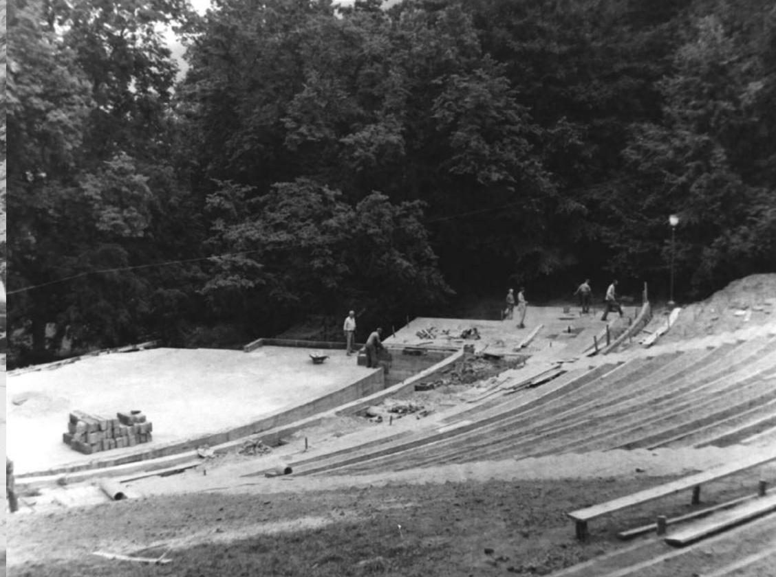
Výstavba stupňovitého hlediště letního kina.
