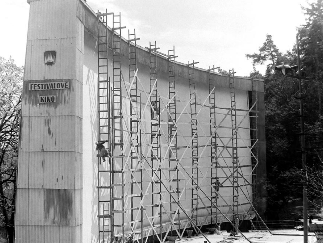
Povrchová úprava /stříkání/ promítacího plátna.
